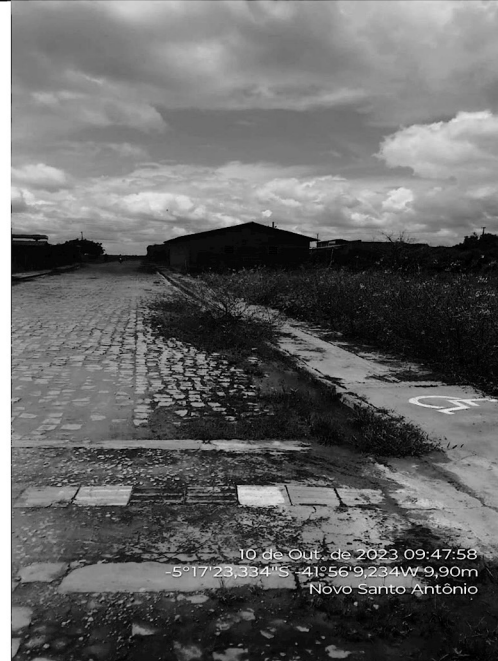
Figura 05- Rua com característica de declive sem escoamento adequado.
