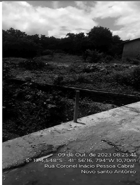
Figura 12- Area de risco de deslizamento de alagamento deixando inapropriado para a construção comercial e residencial no local.
