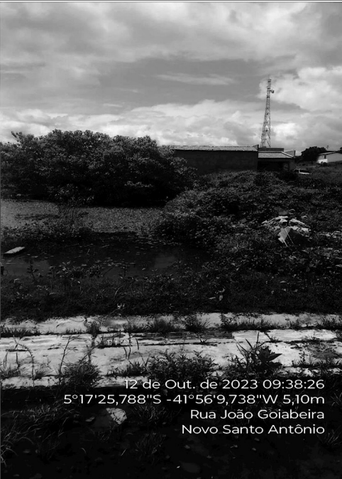
Figura 04- Area propicia a alagamento devido sua baixa topografia.
