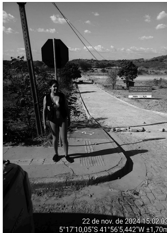
Figura 15- Rua sendo calçada mas ainda sim o declive impede a construção de casa por risco de alagamento.
